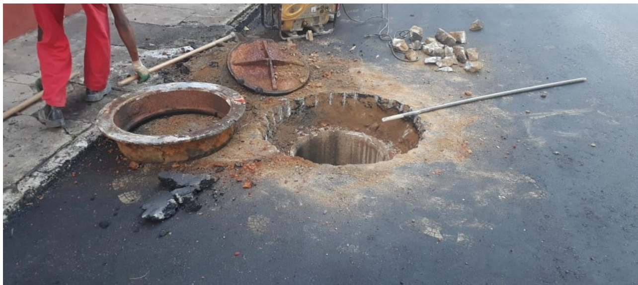
Figura 29 - Retirada do aro e tampa do poço de visita para alteamento.
