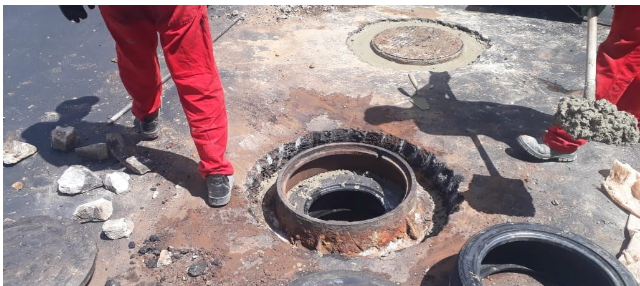
Figura 31 - Chumbamento do aro do poço de visita com concreto. Ao fundo, outro poço de visita já assentado.
