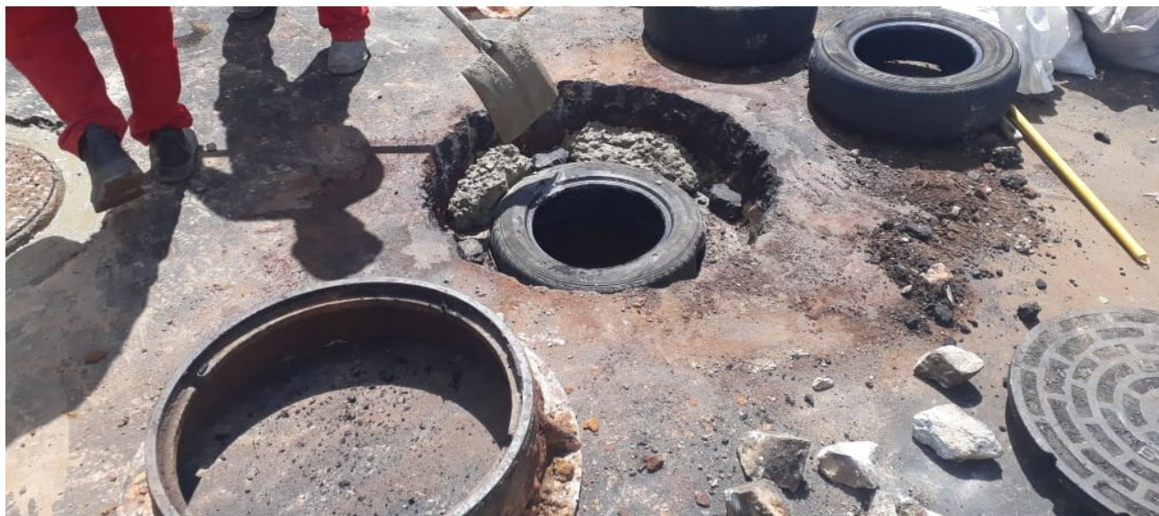
Figura 30 - Concretagem da base utilizando pneu como fôrma.
